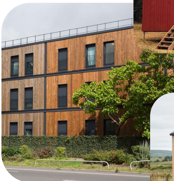
Centre d'hébergement déplaçable en construction modulaire bois
