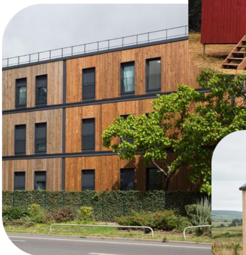
Centre d'hébergement déplaçable en construction modulaire bois Toits Temporaires Urbains
